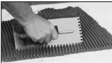
Nota: La instalación de losetas mayores a 46 x 46 cm (18 x 18 pulgadas), puede requerir tiempos de curado mas amplios antes que la loseta pueda ser enlechada o se camine por encima. Para tiempos de entrega más cortos cuando se instalan losetas más grandes, utilice un mortero de contacto completo y de fraguado rápido de NAA, como *NA 3240 Multi Flex™ Rapid*.
